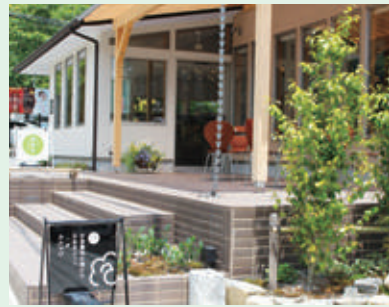
参道に向かう外観。テラスでイベントも出来る。
